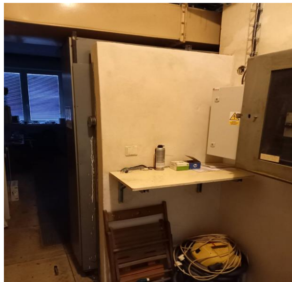
Stávající příčka š.92/t.15/v.200cm za rozvaděčem RC04-1.2 pole 3 bude demontována
