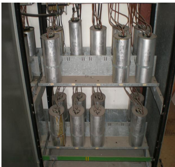
Původní osazení 3. pole RC04-1.2 na bet. soklu, bude stavebně upraven, po osazení nového RK
